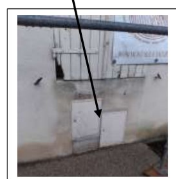
Dépose Branchement aérien + coffrets existant
