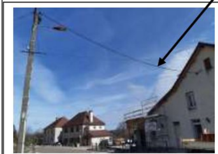
Dépose Branchement aérien + coffrets existant
