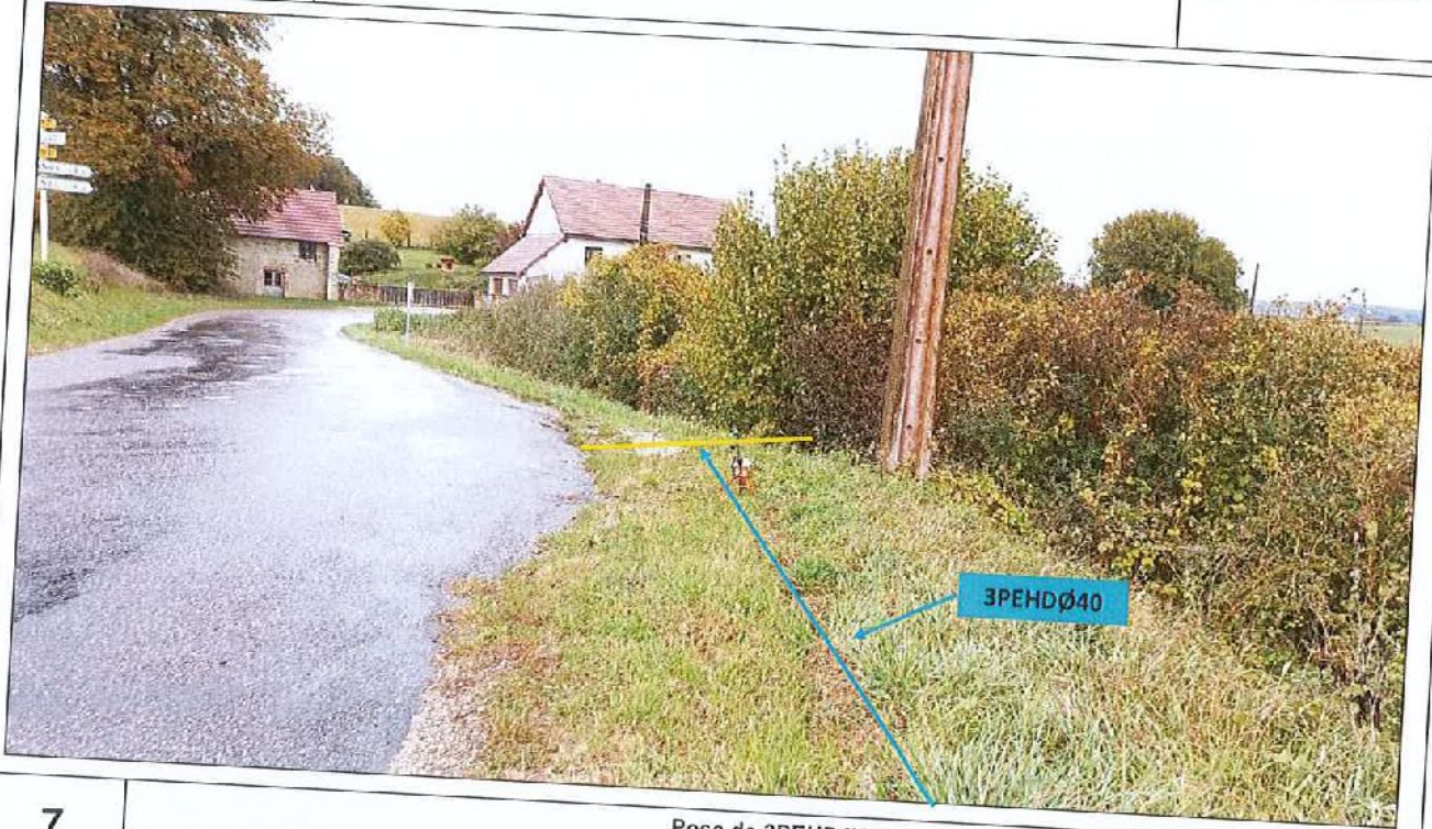
Pose de 3PEHDØ40 Tranchée traditionnelle en terrain naturel Réfection TN
