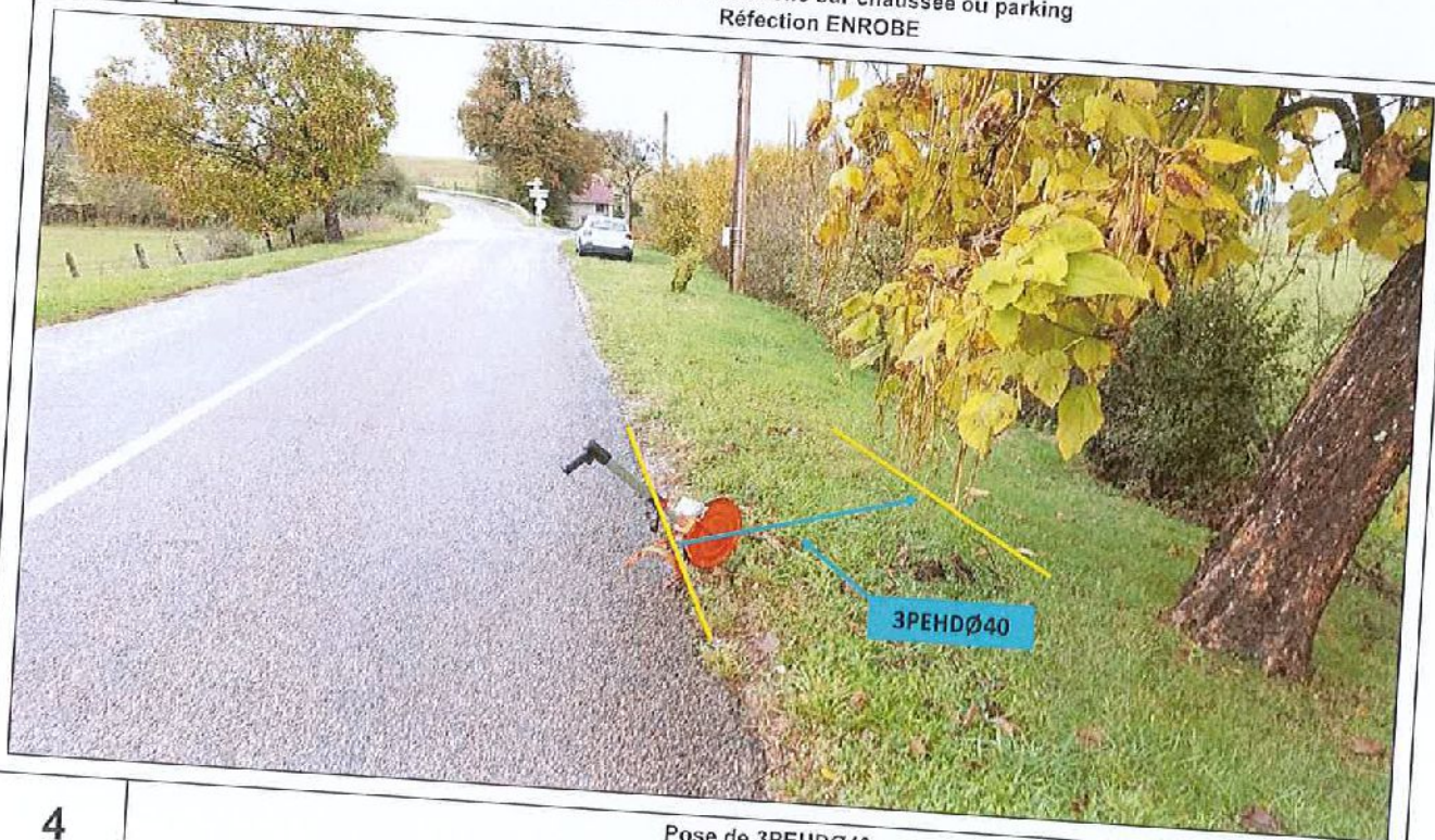
Pose de 3PEHDØ40 Tranchée traditionnelle en terrain naturel Remblai GNT - Réfection TN
