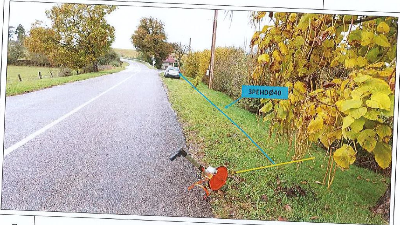
Pose de 3PEHDØ40 Tranchée traditionnelle en terrain naturel Réfection TN
