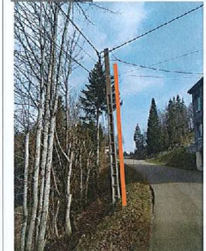
Matériaux : BOIS Hauteur : 8 m
