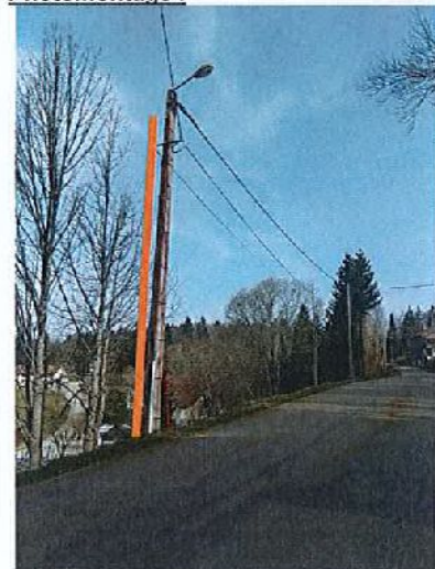
Matériaux : BOIS Hauteur : 8 m
