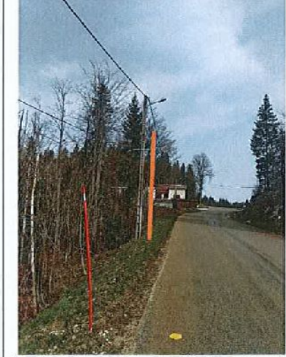
Matériaux : BOIS Hauteur : 8 m
