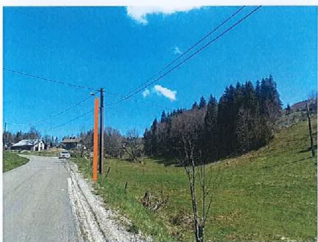
Matériaux : BOIS Hauteur : 8 m
